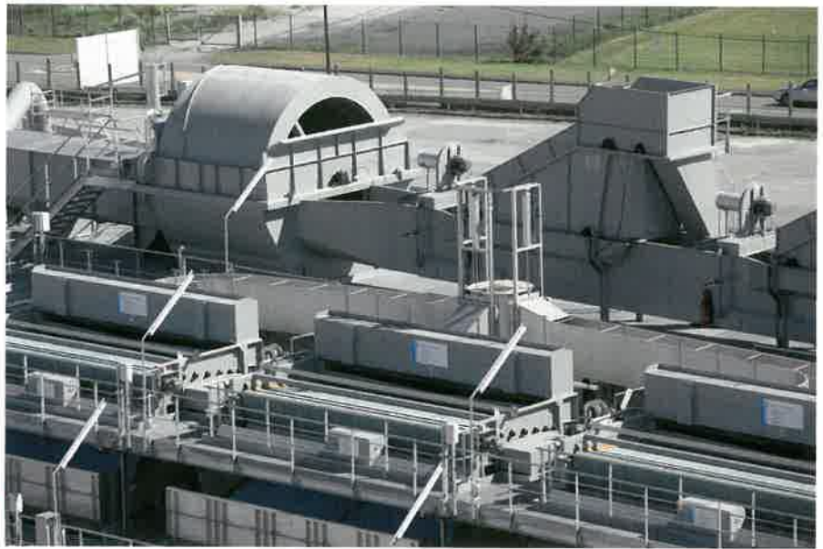
Kundenspezifische Abwandlungen von Maschinen und Anlagen zur Zuckerproduktion bilden das Kerngeschäft bei Putsch – wie dieser Rübenhof
