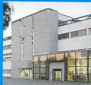
Das Rechenzentrum von All for One Steeb
