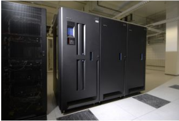
Außenansicht der Taperoboter Foto: All for One Steeb
