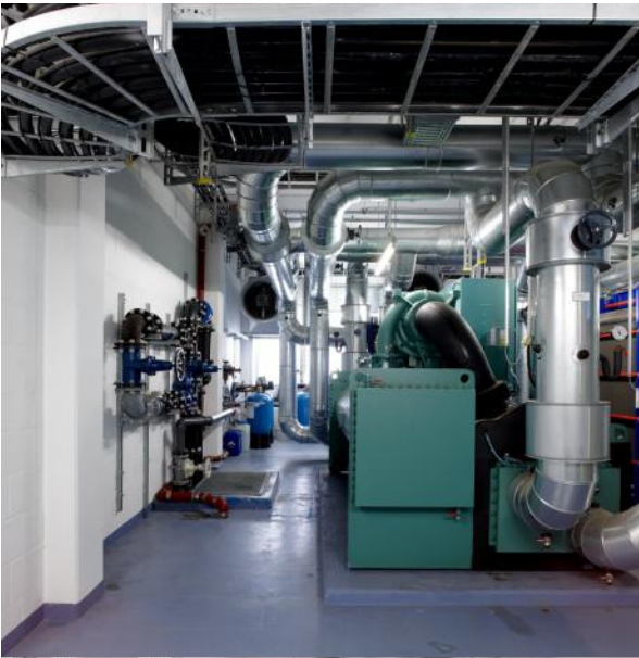
Server im Herz des Rechenzentrums
